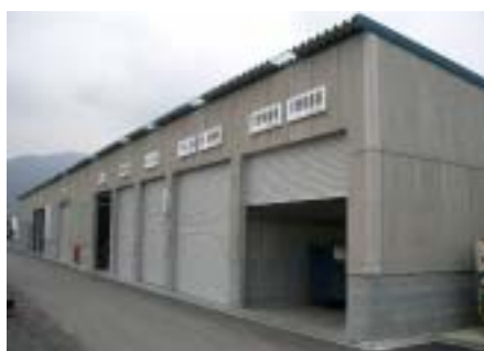
【新設した廃棄物集積場】
